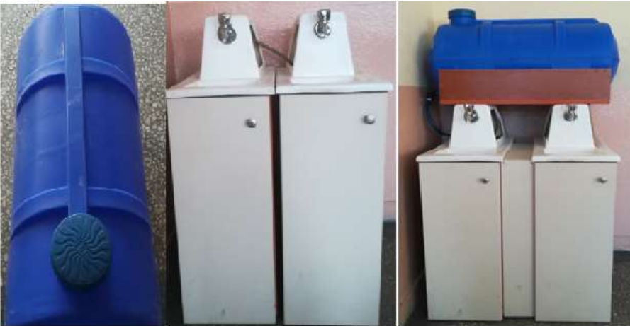
Resim 10: Laboratuvara kurulan seyyar lavabo sistemi.
